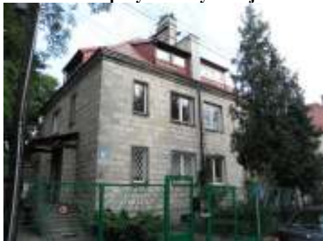
Fot. 31. Dom przy Morszyńskiej 35
