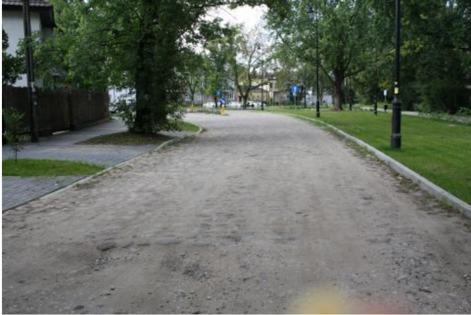
Fot.3 Widok jezdni ulicy Okrężnej na granicy robót.
