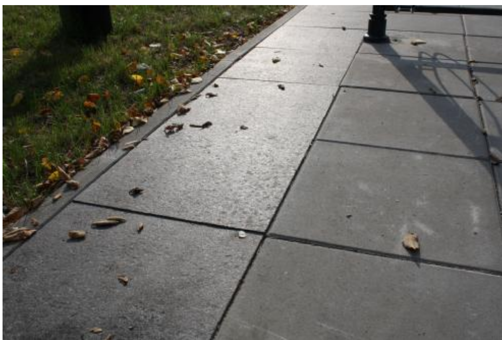
Fot.17 Widok luźno osadzonych płyt bazaltowych (pojedyncza płyta) – Plac Rembowskiego.
