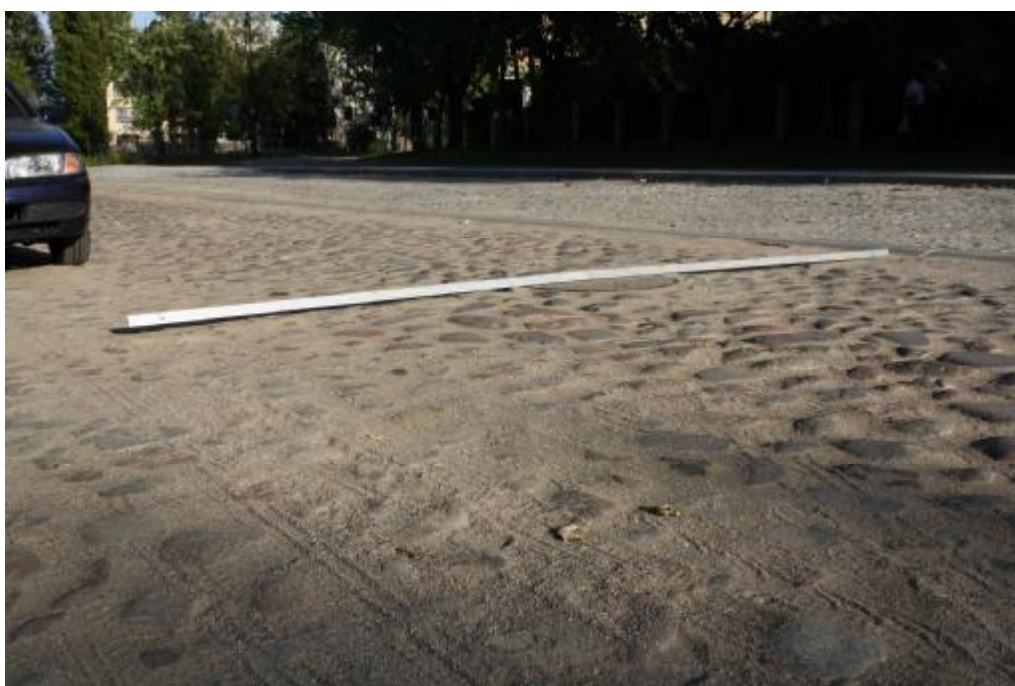
Fot.19 Osadzenie studni w nawierzchni – jezdnia północna na odcinku ul. Cieplicka - Powsińska.
