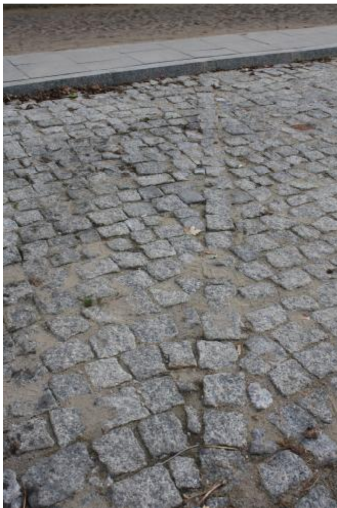
Fot.9 Widok nawierzchni parkingu z kostki kamiennej, widoczne różnice w dobieciu kostek.
