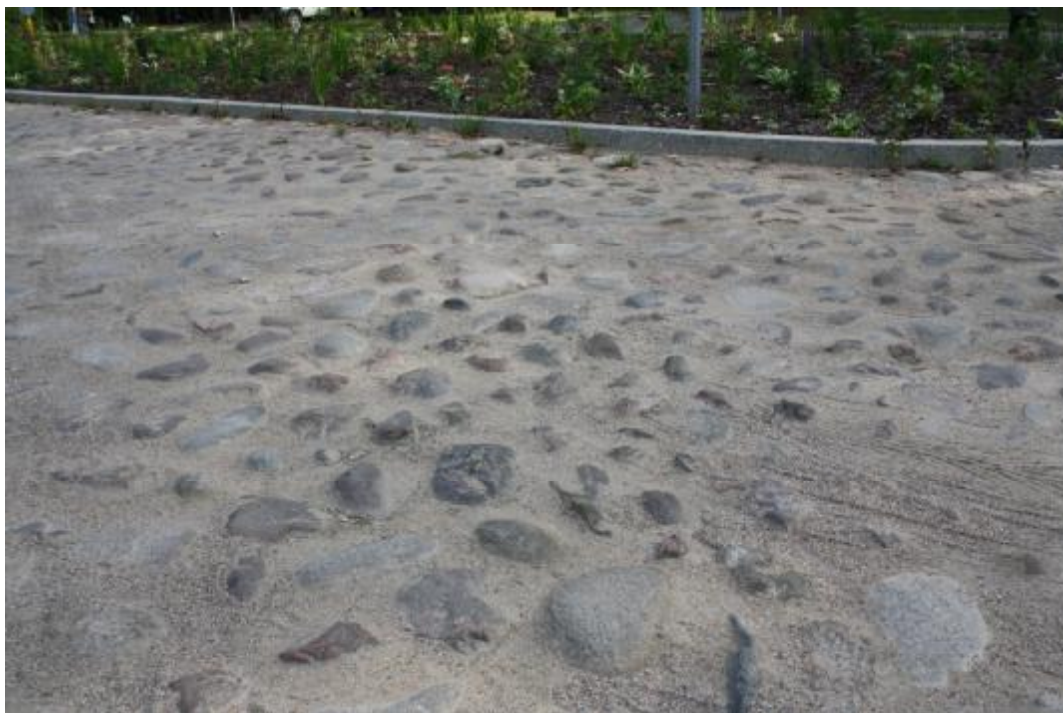
Fot.8 Widok ułożenia poszczególnych kamieni – widoczne wystawanie kamieni ponad poziom pozostałych (kamienie ułożone „na sztorc”).
