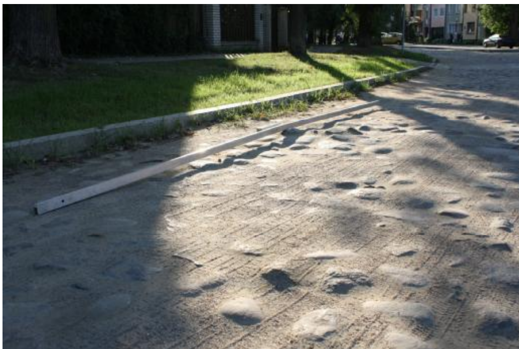
Fot.22 Pomiar nawierzchni – jezdnia południowa rejon Placu Rembowskiego.
