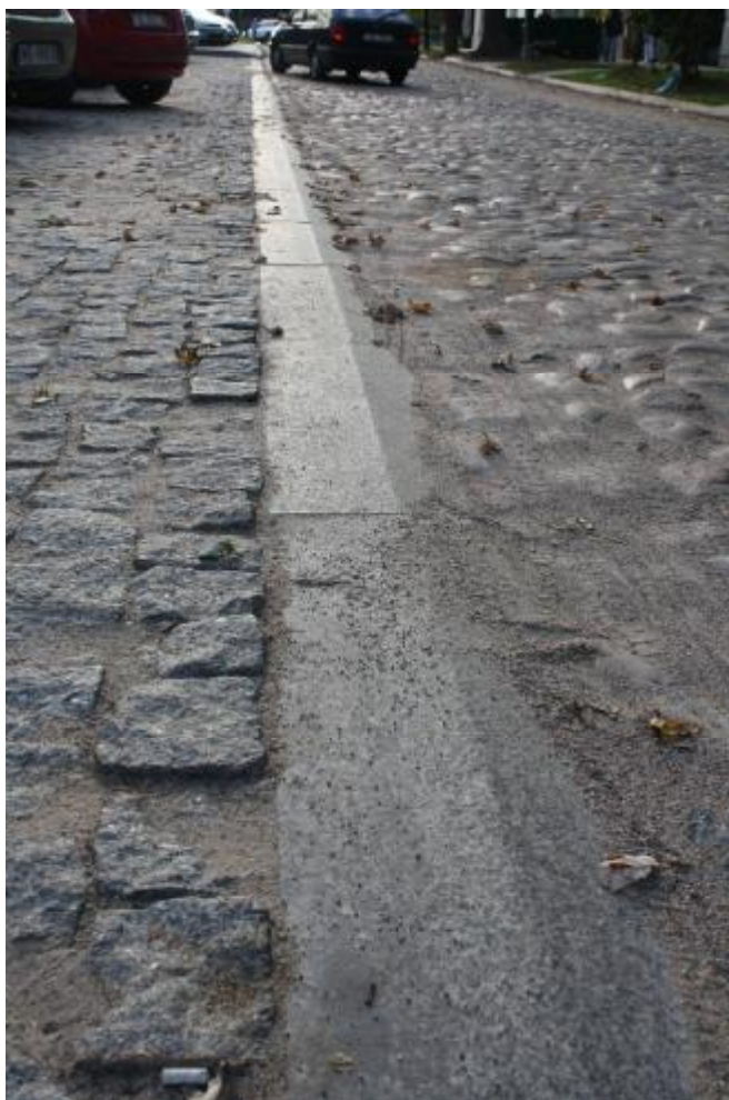
Fot.9 Widok nawierzchni parkingu z kostki kamiennej, widoczne różnice w dobieciu kostek.
