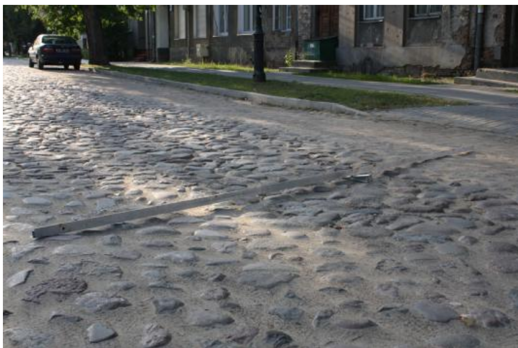
Fot.23 Pomiar nawierzchni – jezdnia północna odcinek Plac Rembowskiego - Cieplicka.
