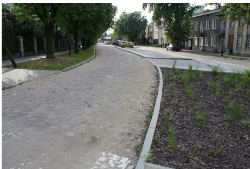
Fot.2 Widok jezdni ulicy Okrężnej od strony ul. Jeziornej.
