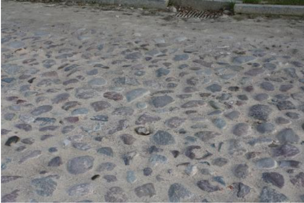
Fot.4 Widok ułożenia poszczególnych kamieni – widoczne różnice wielkości kamieni.
