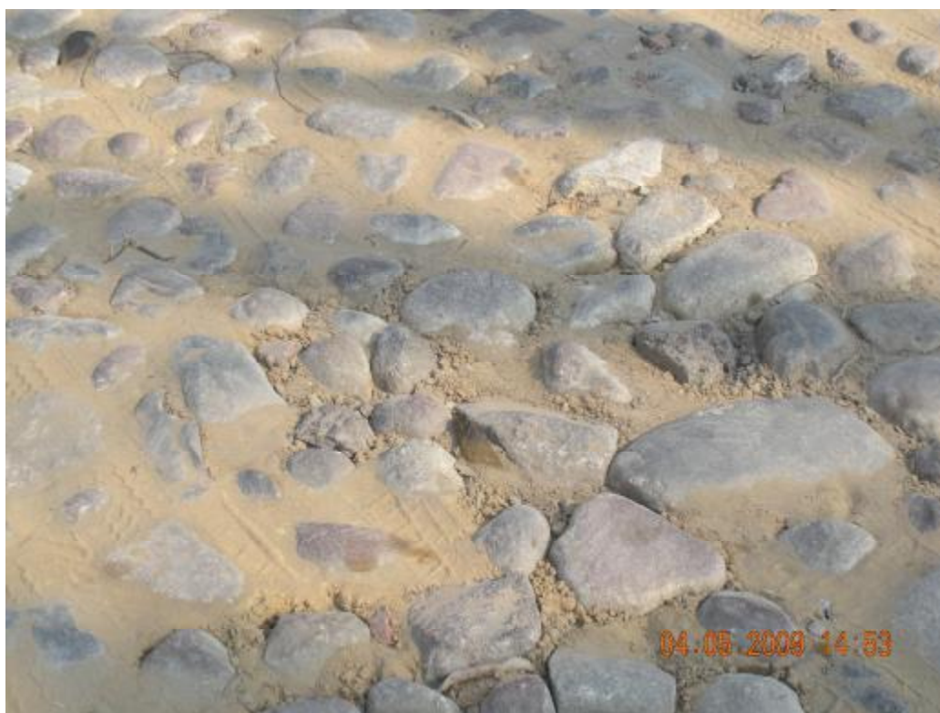
Fot.7 Widok ułożenia poszczególnych kamieni – fot. Przekazana przez Zamawiającego, wyraźnie widać przypadkowy dobór wielkości kamieni.
