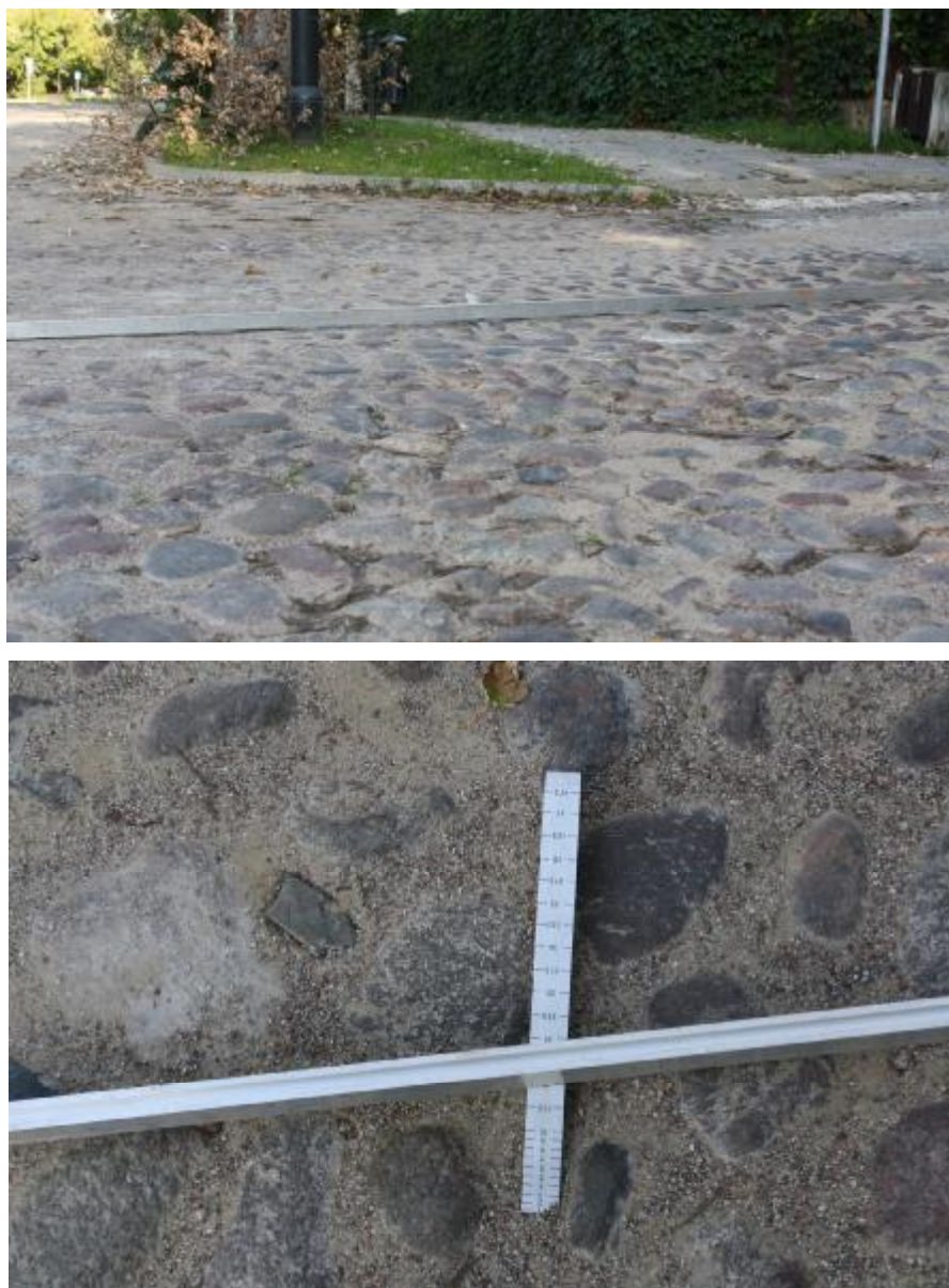
Fot.18 Pomiar nawierzchni – skrzyżowanie z ul. Morszyńską.
